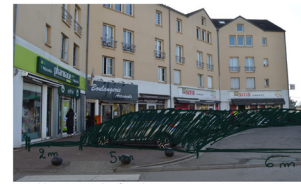
La voirie opprime les façades
